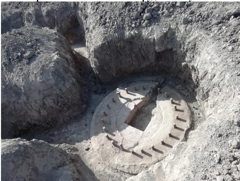
К этому бетонному основанию 24-мя болтами крепились нижняя часть орудийной тумбы
