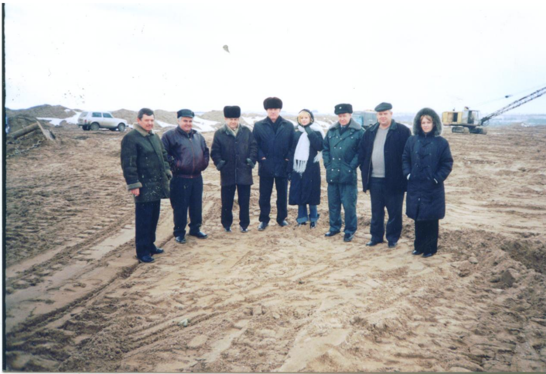
Фото № 12 «Закладка площадки под строительство домов».
